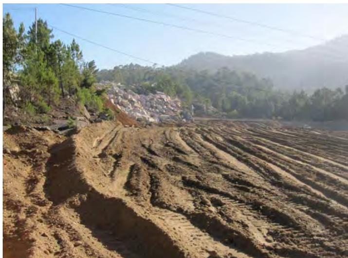
**Fotografía nº 15:** explanación y restos de la piedra extraída de la antigua cantera, tras el arbolado original.
